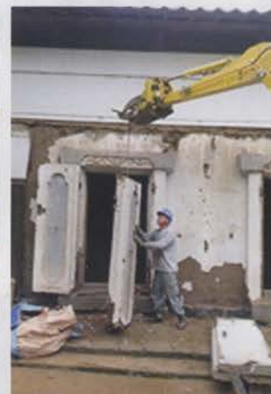
▲下屋根を取りはずし土蔵の扉を外しました
