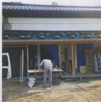
▲下屋根の再設の様子ですが、この時期はまだ内装にはかかっていません。でも丁寧な仕事をされる大工さんのお陰で綺麗な下屋根が出来ています。
